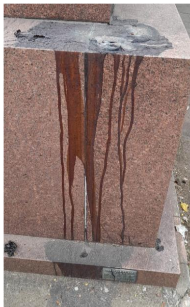
Figura 34: Depósito em túmulo, provavelmente causado por velas derretidas.
