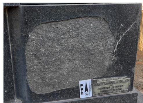
Figura 27: Deslocamento na lateral de um túmulo.
