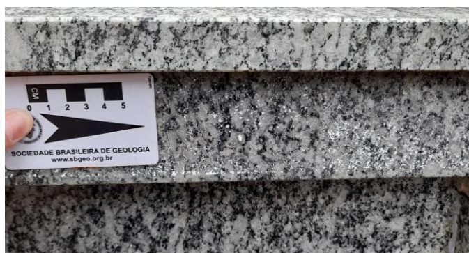
Figura 36: Eflorescência de sais em granito
