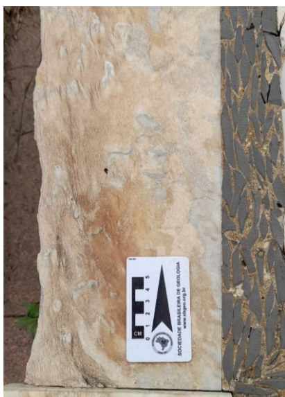
Figura 29: Erosão diferencial em bloco de mármore em um túmulo.
