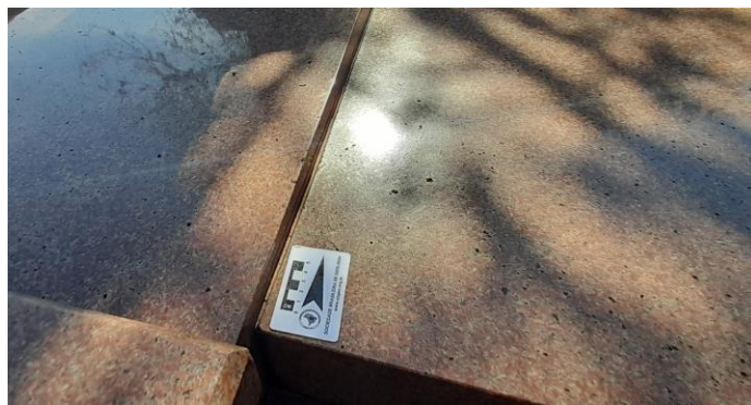
Figura 30: Pitting encontrado tipicamente no Granito Rosa Itupeva. Especula-se ocorrer devido aos minerais com ferro que são corroídos pelo intemperismo.
