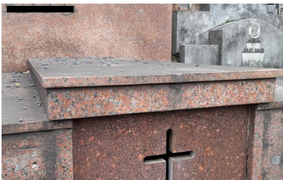
Figura 23: Deformação na parte superior de um túmulo em Granito Rosa Salto.
