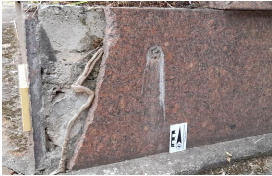
Figura 21: Fratura no revestimento da base de um túmulo. Há também colonização biológica, com raiz provocando a fragmentação da placa de revestimento.
