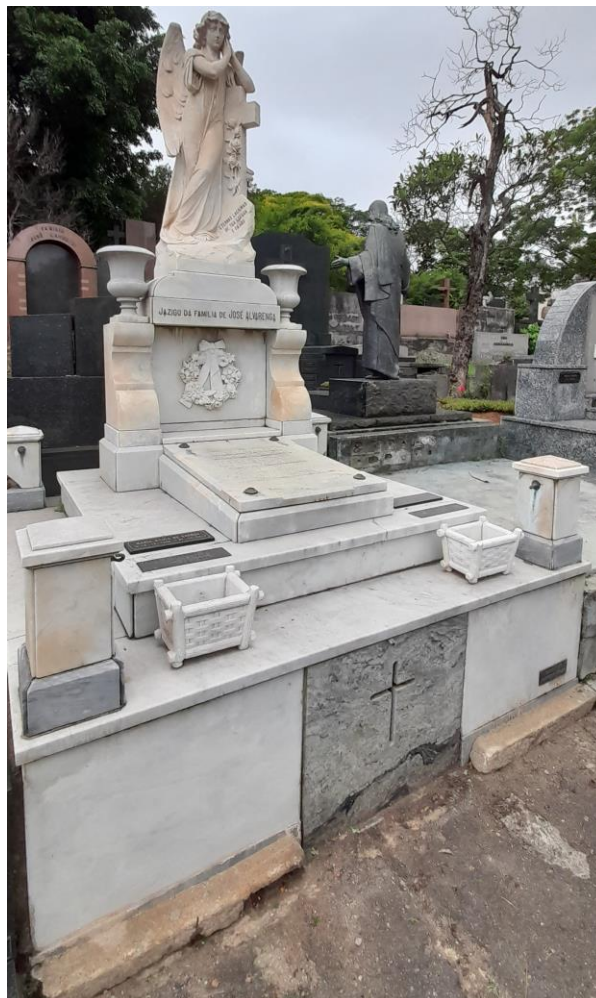
Figura 59: Túmulo Orlando de Oliveira Alvarenga, em mármore, onde é possível ver sugaring e manchas.
