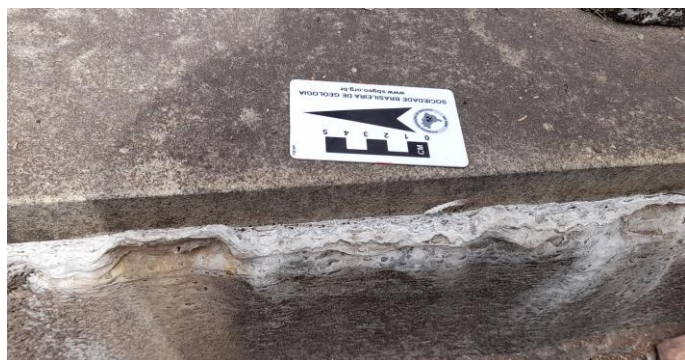
Figura 32: Concreção de concreto na parte superior de um túmulo
