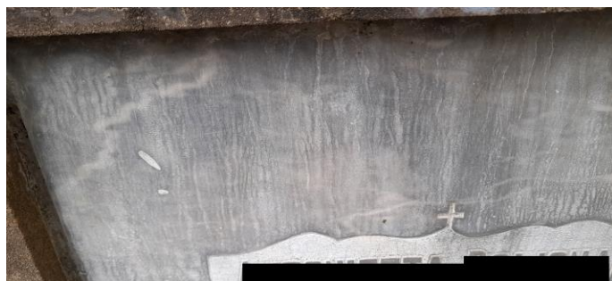
Figura 31: Microcarsificação em mármore na frente de túmulo
