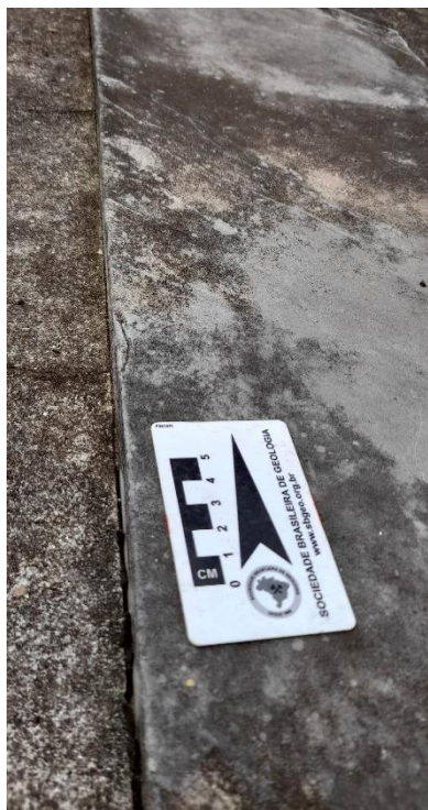
Figura 33: Crosta recobrindo um túmulo.
