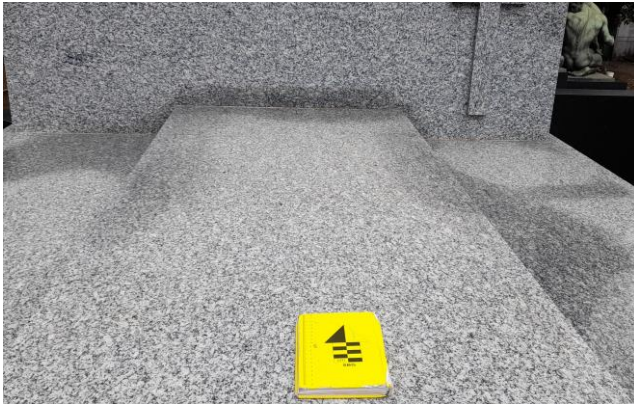
Figura 38: Manchas de umidade em túmulo de Granito Cinza Mauá.
