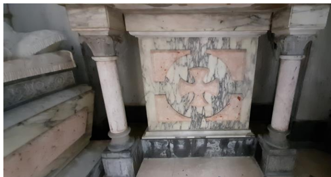
Figura 35: Descoloração de mármore no interior de uma capela.
