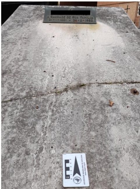
Figura 22: Fissura na parte superior de um túmulo.
